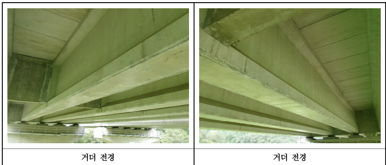
【사진 9.3.29】 거더 전경
