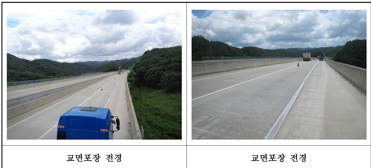
【사진 9.3.44】 교면포장 전경
