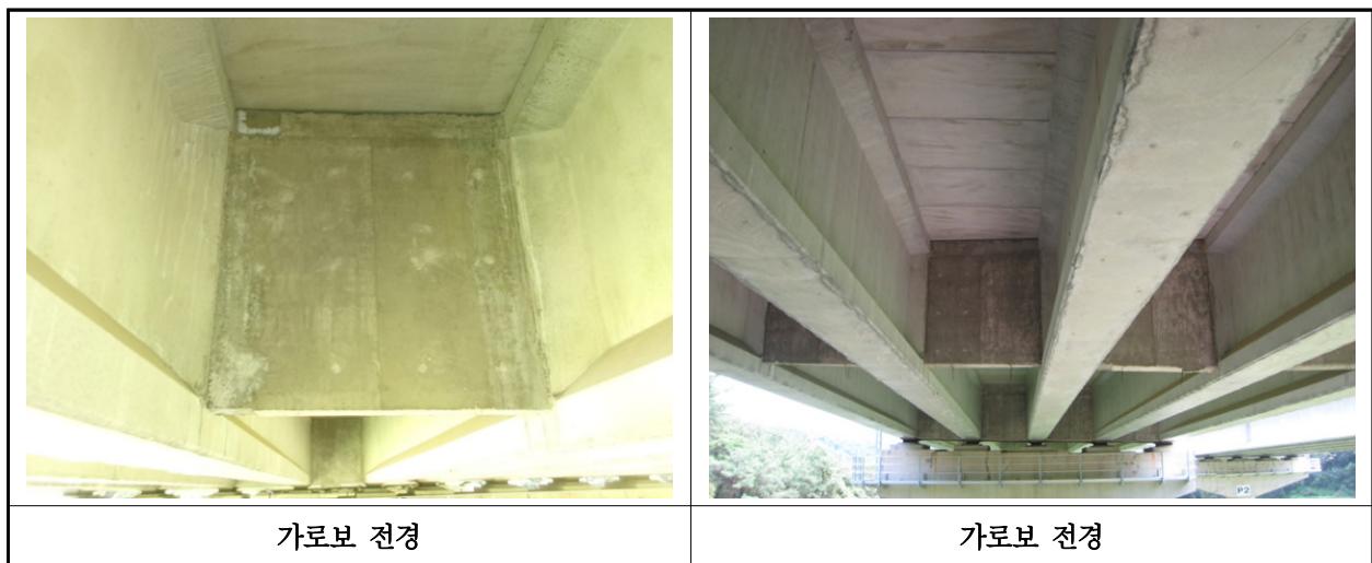
【사진 9.3.6】 가로보 전경
