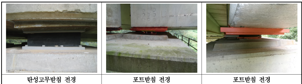
【사진 9.3.37】 교량반침 전경
