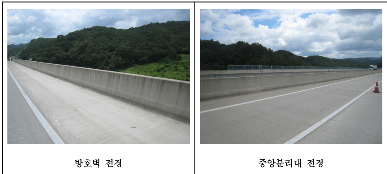
【사진 9.3.48】 방호벽 및 중앙분리대 전경
