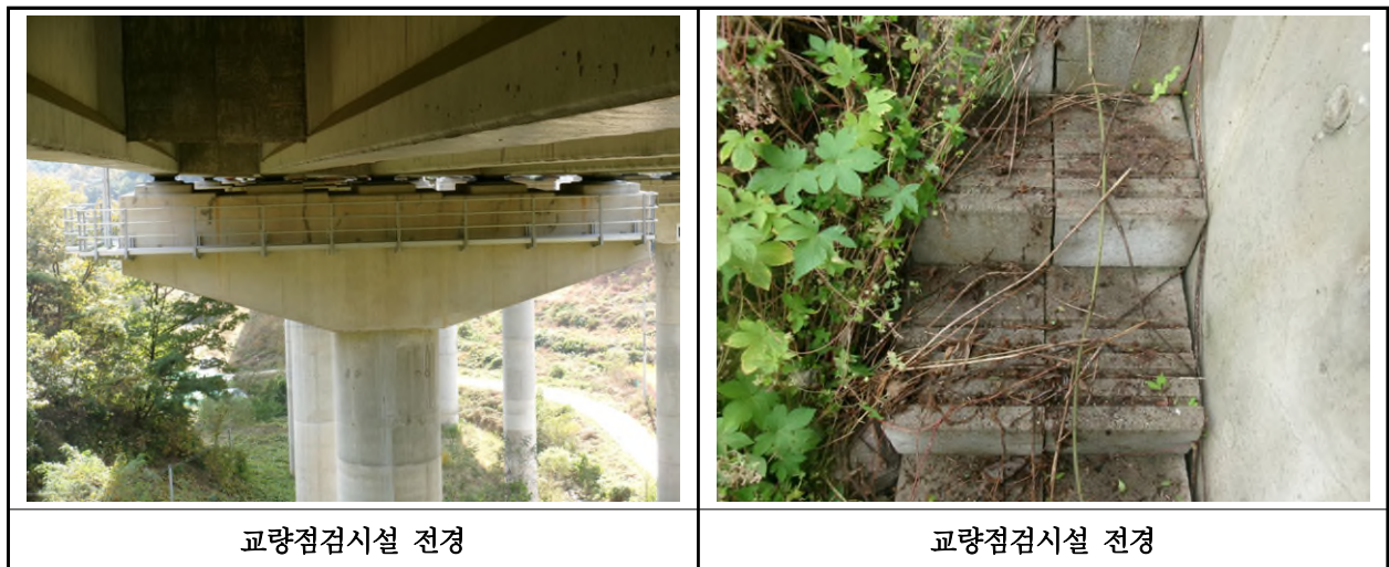
【사진 9.3.50】 교량 점검시설 전경
