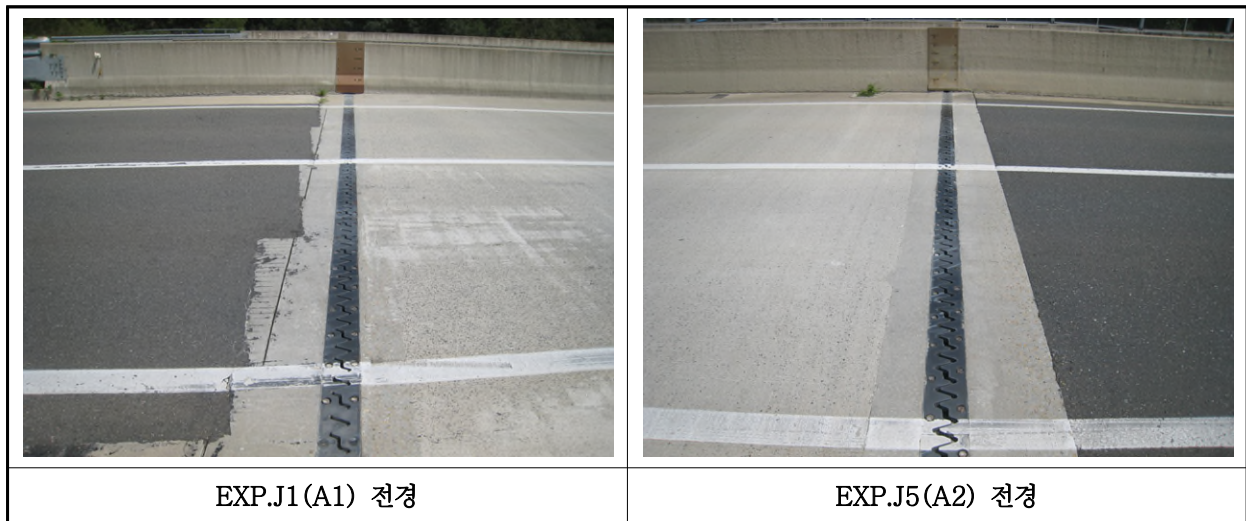
【사진 9.3.41】 신축이음장치 전경
