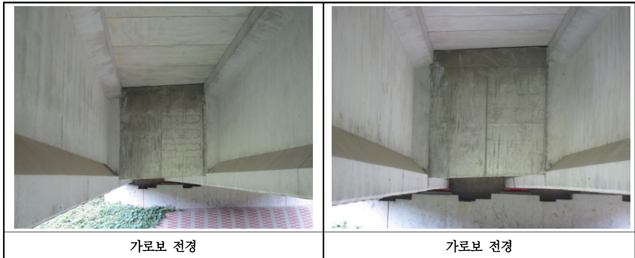
【사진 9.3.31】 가로보 전경
