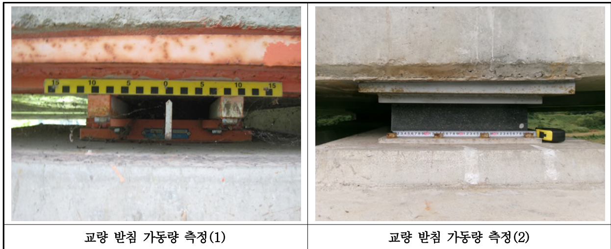
【사진 9.3.15】 교량받침 이동량 측정
