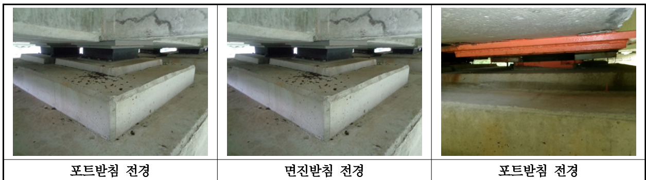
【사진 9.3.12】 교량반침 전경
