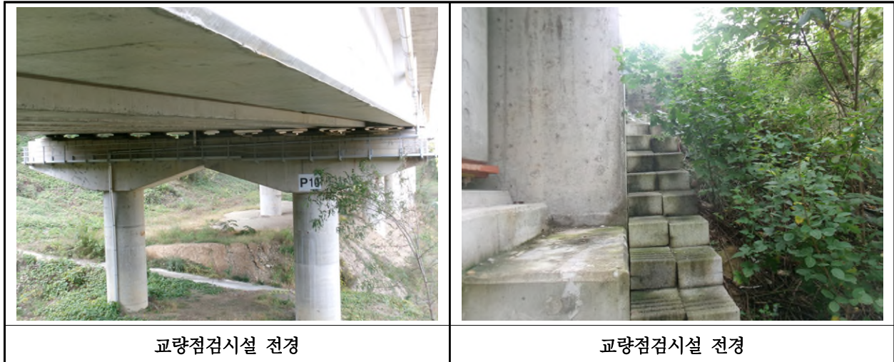
【사진 9.3.25】 교량 점검시설 전경
