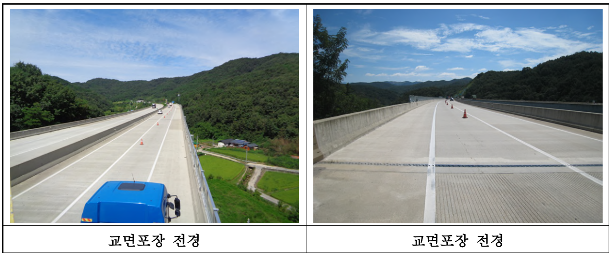
【사진 9.3.19】 교면포장 전경
