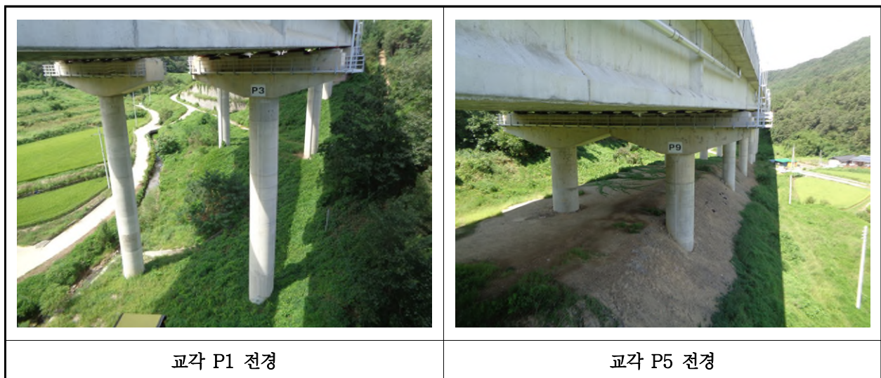
【사진 9.3.10】 교각 전경
