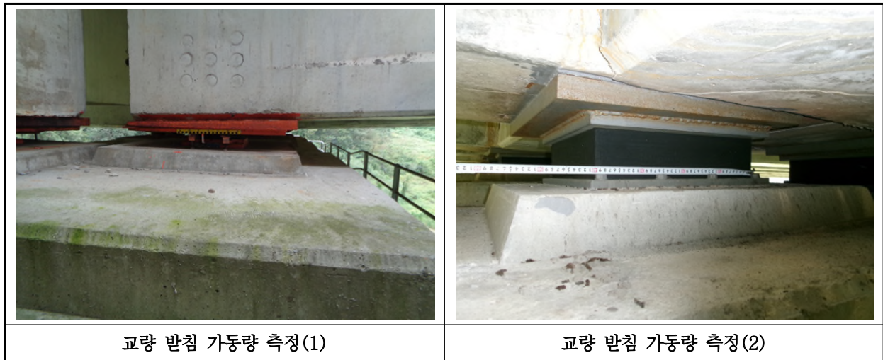
【사진 9.3.40】 교량받침 이동량 측정
