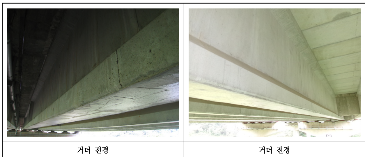
【사진 9.3.4】 거더 전경
