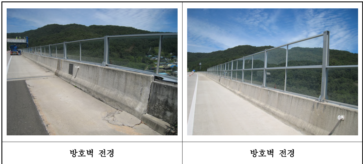
【사진 9.3.23】 방호벽 및 중앙분리대 전경
